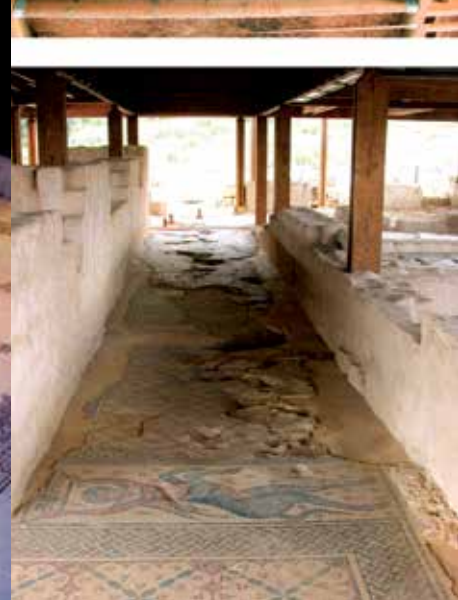
▲ איור 7 | ציפוי הנחושת של הגג גורם לעיבוי, ובמקומות שבהם שיפוע הגג אינו מספיק להולכת המים החוצה, המים מטפטפים באופן ישיר על הפסיפס
