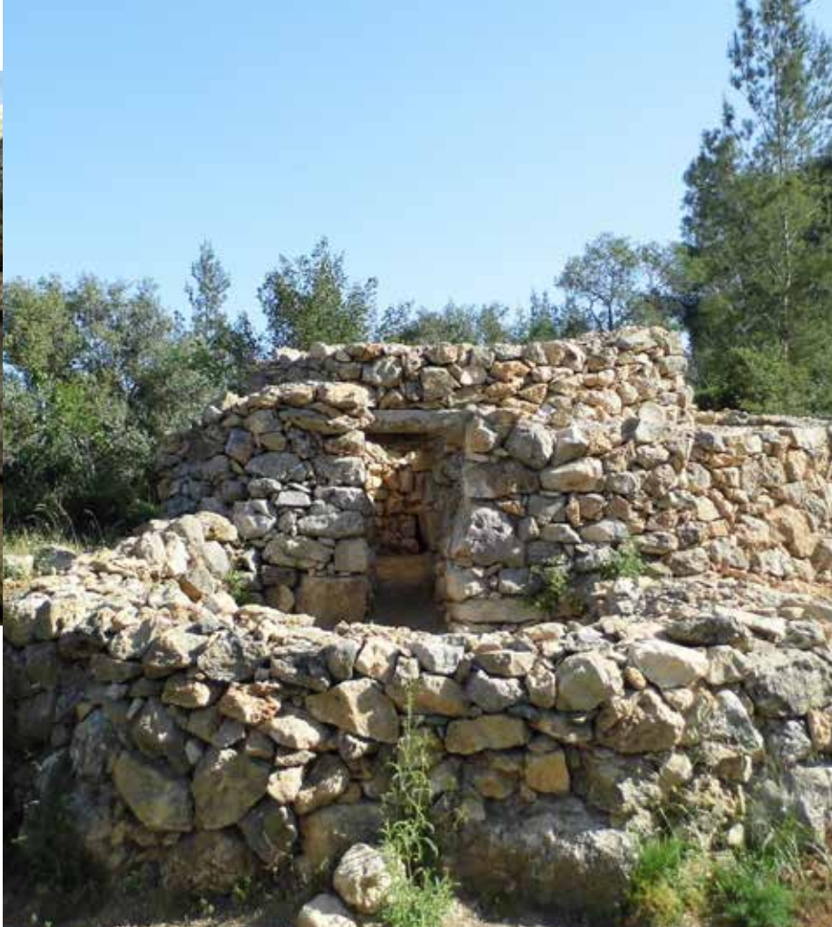
חלל השומרה בזמן העבודות הרחקת אדמה מליבת השומרות ובנייה מחדש של הדופן החיצונית
