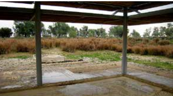
▲ איור 4 | בשנת 2009 הוחזר הפסיפס לאתרו על תשתית חדשה מחומר מליטה על בסיס סיד. ביום גשם נראה, כי סביבת האתר מנוקזת היטב, אך מים דולפים מהגג בשל כשל בחיבורים של לוחות החיפוי
