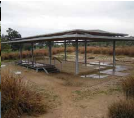
▲ איור 3 | תכנון מחודש של האתר כלל החלפה של הגג וטיפול בניקוז מי הנגר באתר
