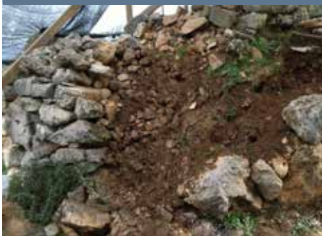
חלל השומרה בזמן העבודות הרחקת אדמה מליבת השומרות ובנייה מחדש של הדופן החיצונית
