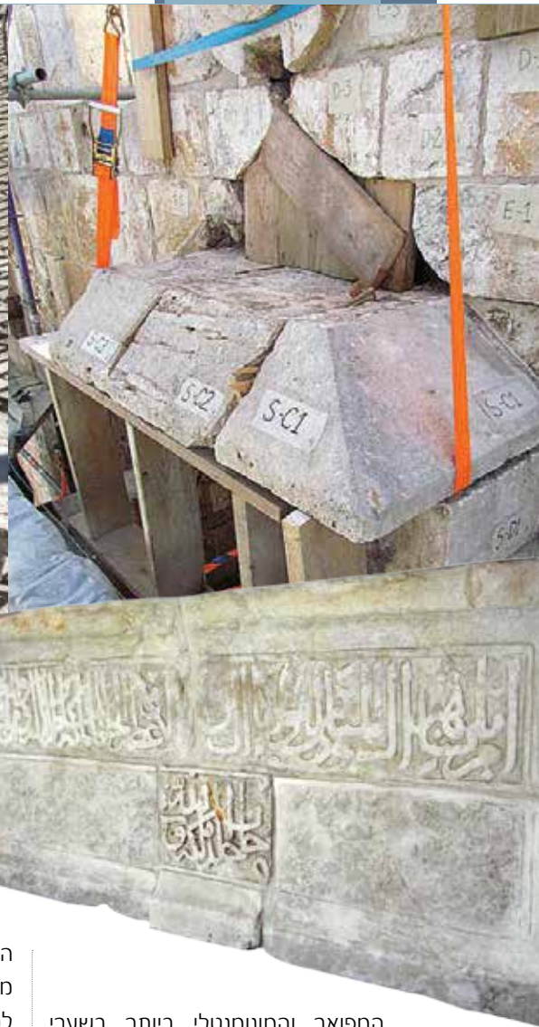
■ בנייה מחדש של אשנב היריה בשער האריות כתובת שער שכם לאחר עבודות השימור
