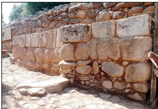
מראה כללי של אזור הפעולה. למעלה משמאל: קטע קיר עם אבנים גדולות וקלינים.
